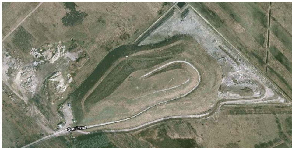
Rys. 1. Składowisko Lipiny Stare. Bryła rekultywowanej części składowiska i nowa kwatera - po lewej (źródło: http://maps.google.pl )
